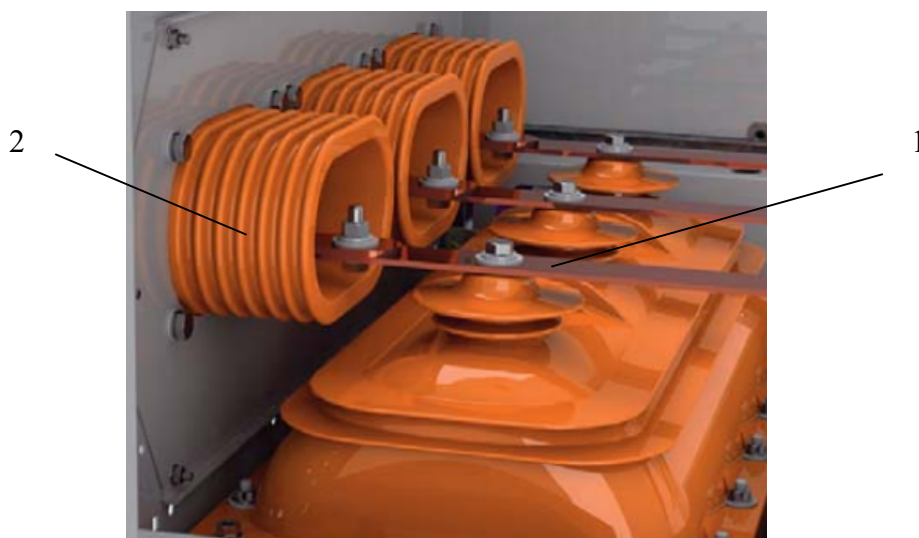
Рис. 18а. Монтаж сборных шин 1 – сборные шины; 2 – проходные изоляторы (3 шт.)
