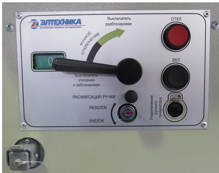
Рис. 6в Рукоятка отключения заблокирована.
